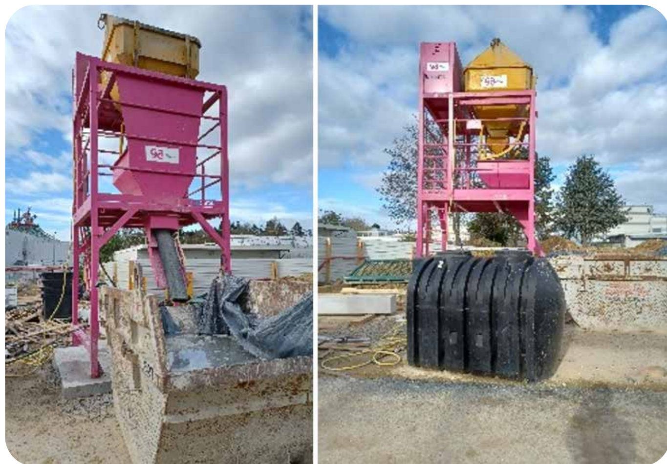
Circuit mis en place sur le chantier Merlin II
