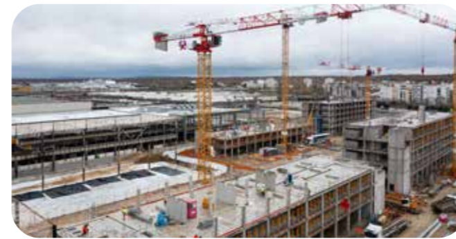
Chantier hors-site du grEEn-campus Stellantis à Poissy
