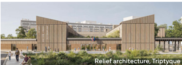
Groupe scolaire Henri Wallon, à Gennevilliers
