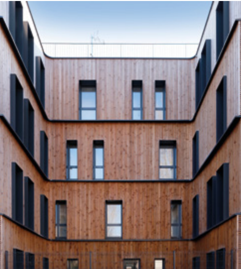
↑ Logements en structure bois, Enghien-les-Bains (95) - TRAA ©Graphix-Images - Augusto da Silva
