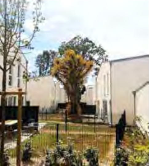
→ Toit et Joie au Perray-en-Yvelines un lotissement de 33 maisons, (33) - SKP architecture
